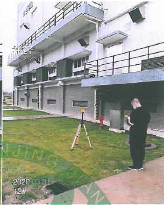
图 1.13 项目监测点 12# (距输出电缆渠 5 米, 距变电站 5 米)
