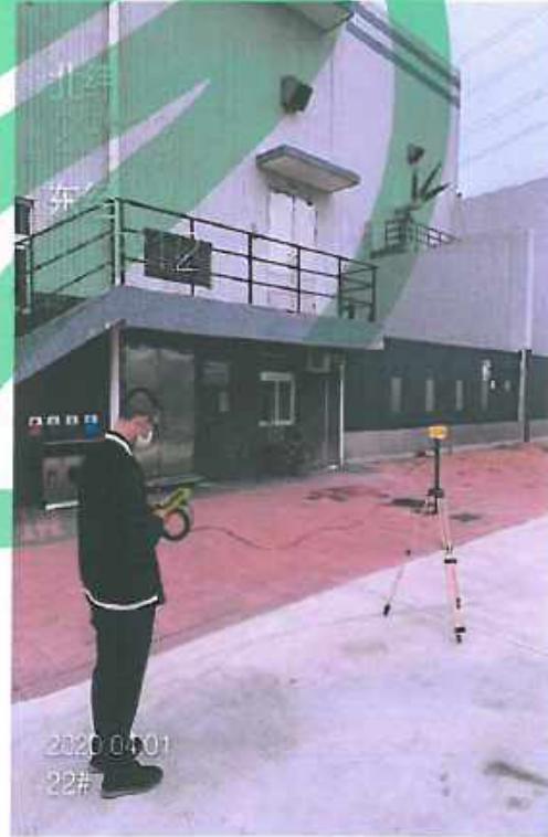
图 1.23 项目监测点 22# (距输入地下缆线 5 米, 距变电站 5 米)
