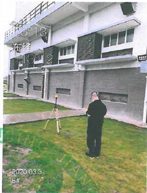
图 1.9 项目监测点 8# (距输出电缆渠 1 米, 距变电站 5 米)
