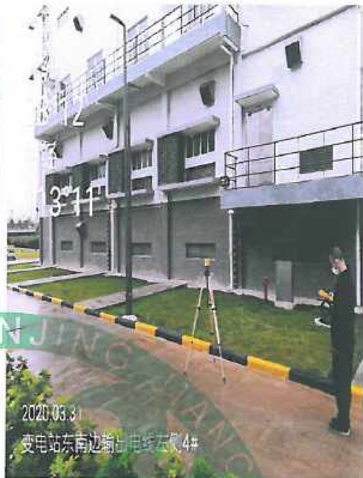
图 1.5 项目监测点 4# (距输出电缆渠 2 米, 距变电站 5 米)
