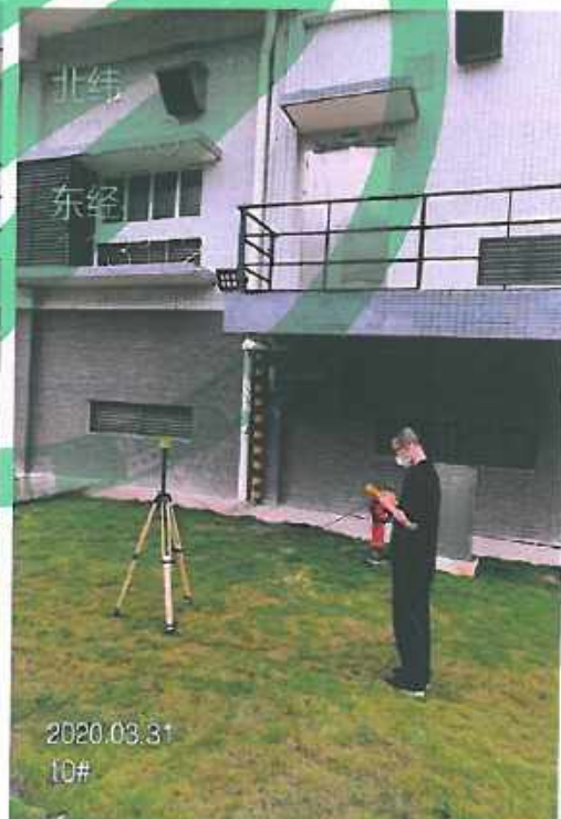
图 1.11 项目监测点 10# (距输出电缆渠 3 米, 距变电站 5 米)
