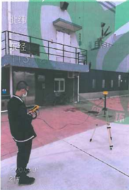
图 1.22 项目监测点 21# (距输入地下缆线 4 米, 距变电站 5 米)
