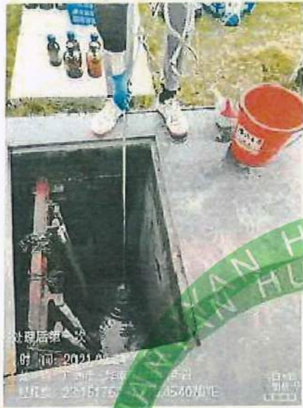
生活污水处理后排放口
